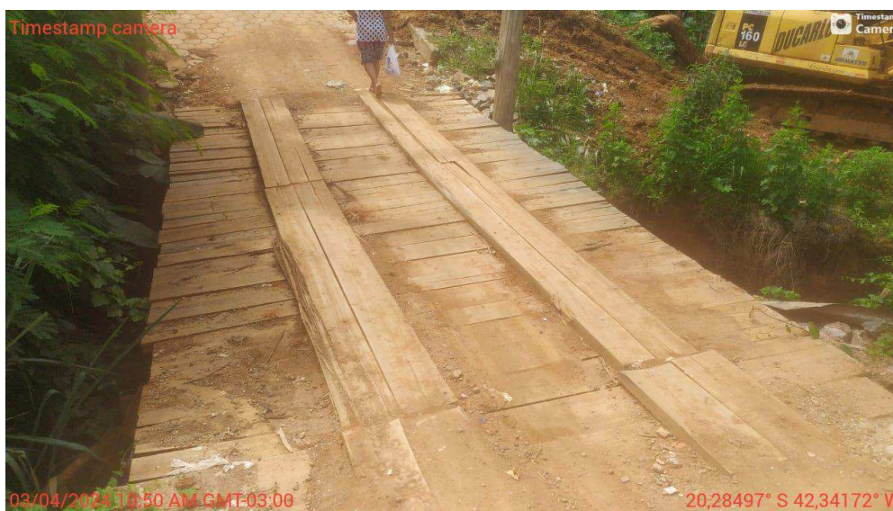
Foto 1 – Ponte da Rua Beira Rio – Frontal
