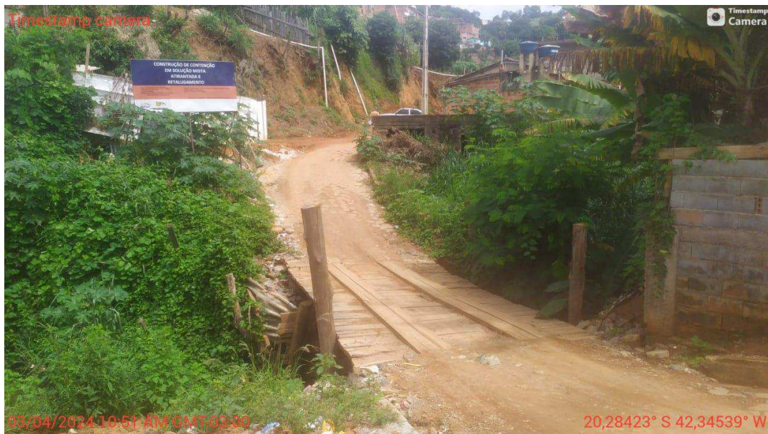
Foto 2 – Ponte da Rua Beira Rio – Lateral
