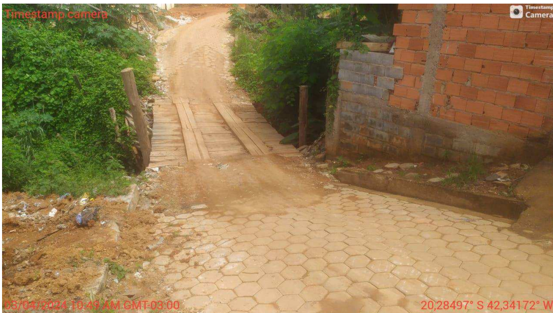
Foto 5 – Ponte da Rua Beira Rio – Lado oposto a chegada
