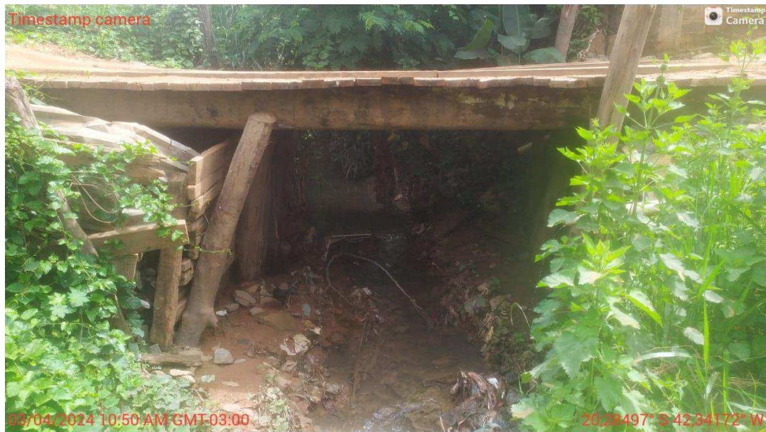
Foto 3 – Ponte da Rua Beira Rio – Parte de baixo da ponte.
