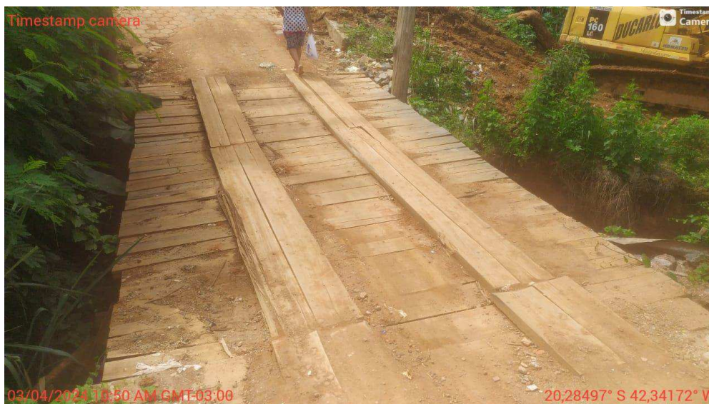
Foto 1 – Ponte da Rua Beira Rio – Frontal
