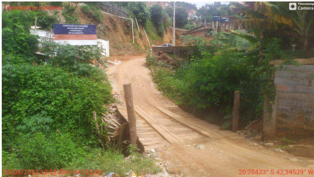
Foto 2 – Ponte da Rua Beira Rio – Lateral
